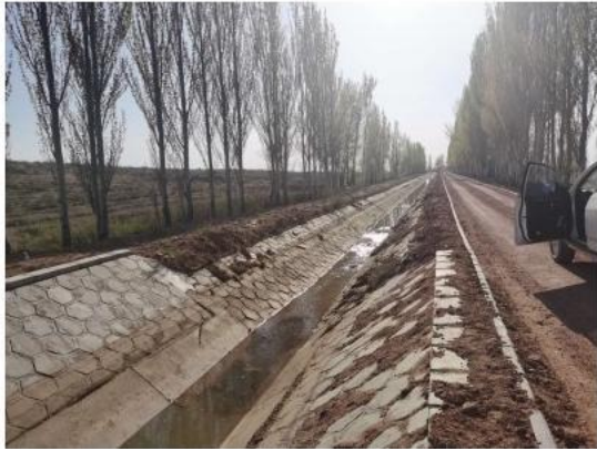
图4.2-5 三道井干渠现状图5
