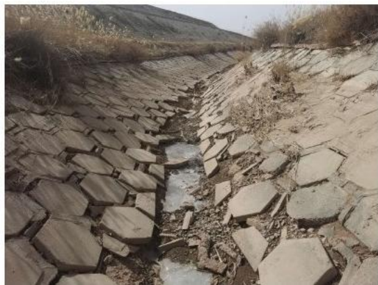
图4.2-3 三道井干渠现状图3
