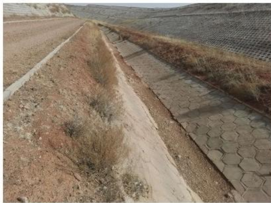
图4.2-1 三道井干渠现状图1
