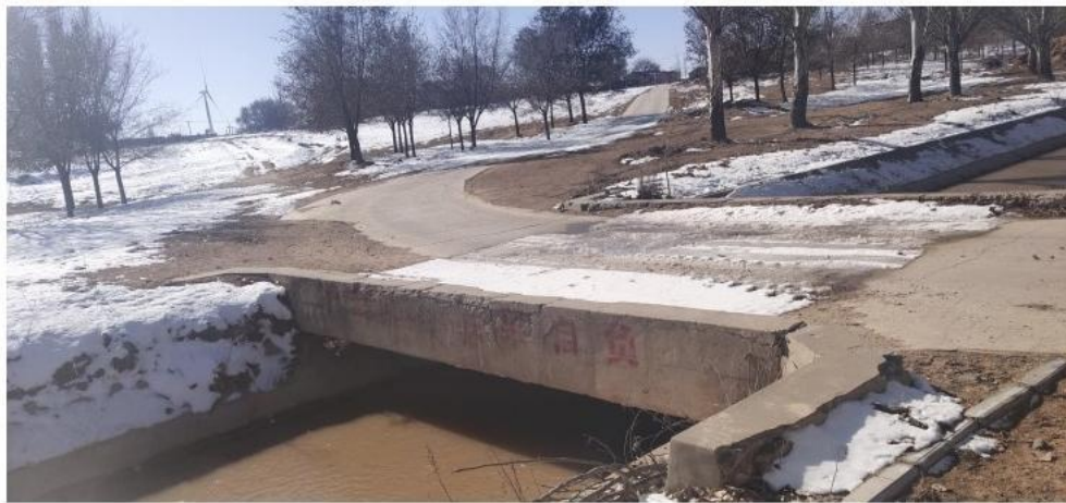
图4.2-7 三道井干渠生产桥现状图6
