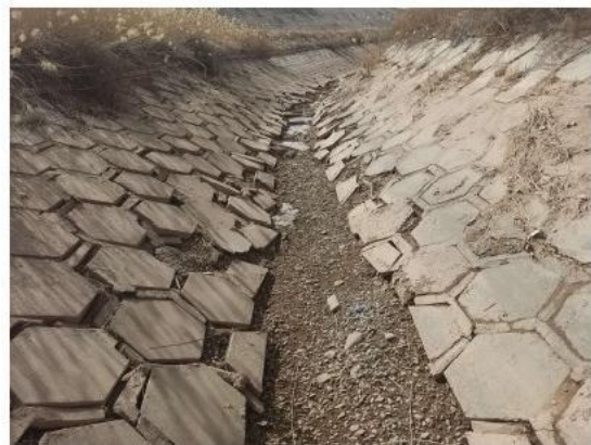
图4.2-4 三道井干渠现状图4
