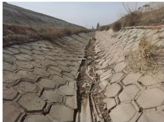
图4.2-2 三道井干渠现状图2
